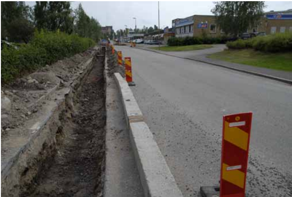
Figur 5 Fjärroärmeschaktet längs med Yxhammargatans östra sida, sett från Nybrogatan i NV.
