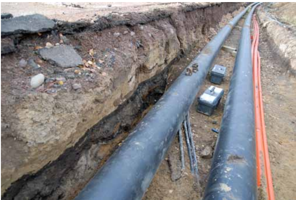
Figur 6. Foto taget från öster med anläggning 3 i schaktväggen. Fotograf Britt-Marie Hägerman.
