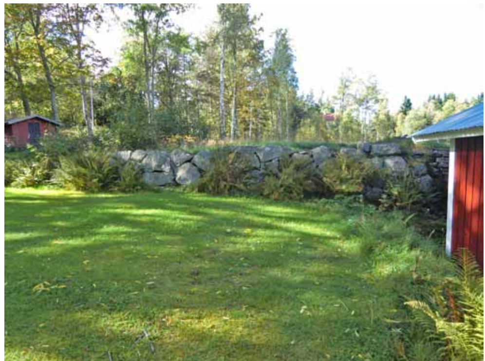
Figur 5. Kallmurat parti av dammvallen fotograferat från sydöst. Foto: Greger Bennström.
