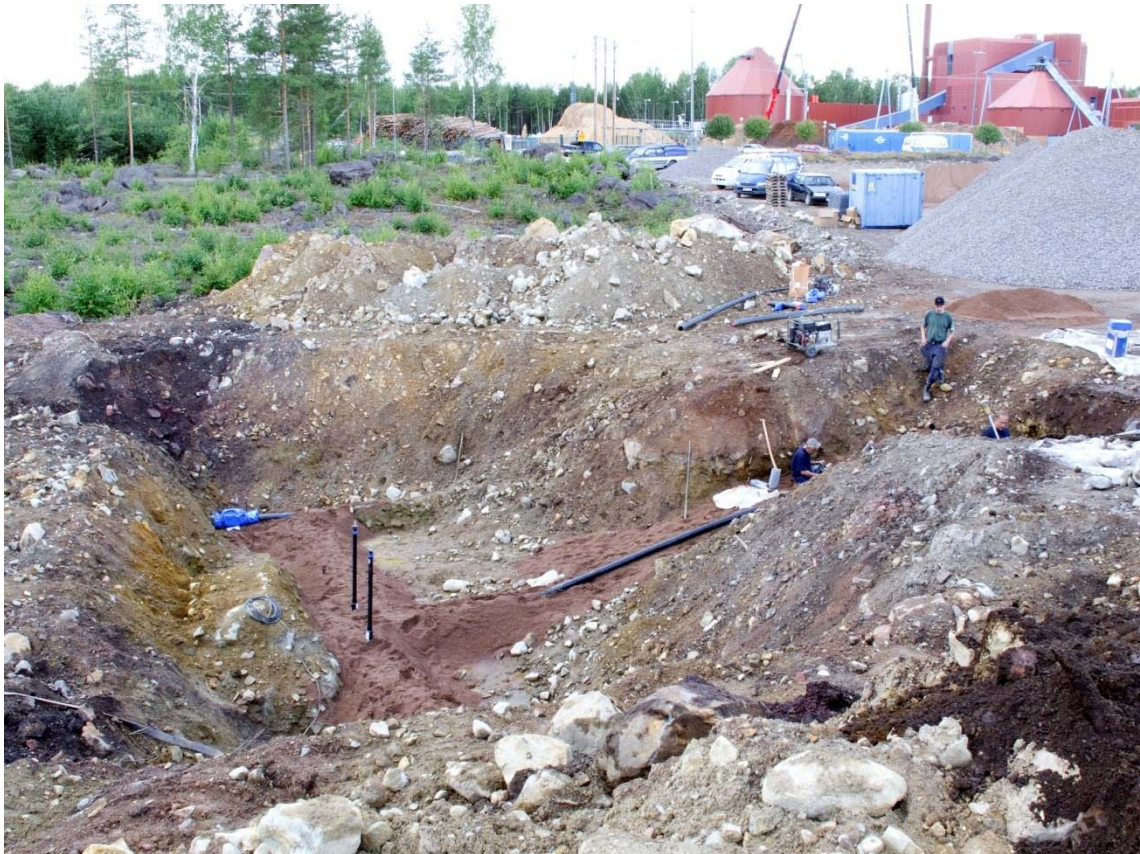
Schaktet för att skarva på vattenledning söder om begränsningslinje. Sett från SÖ. Foto: Fredrik Sandberg
