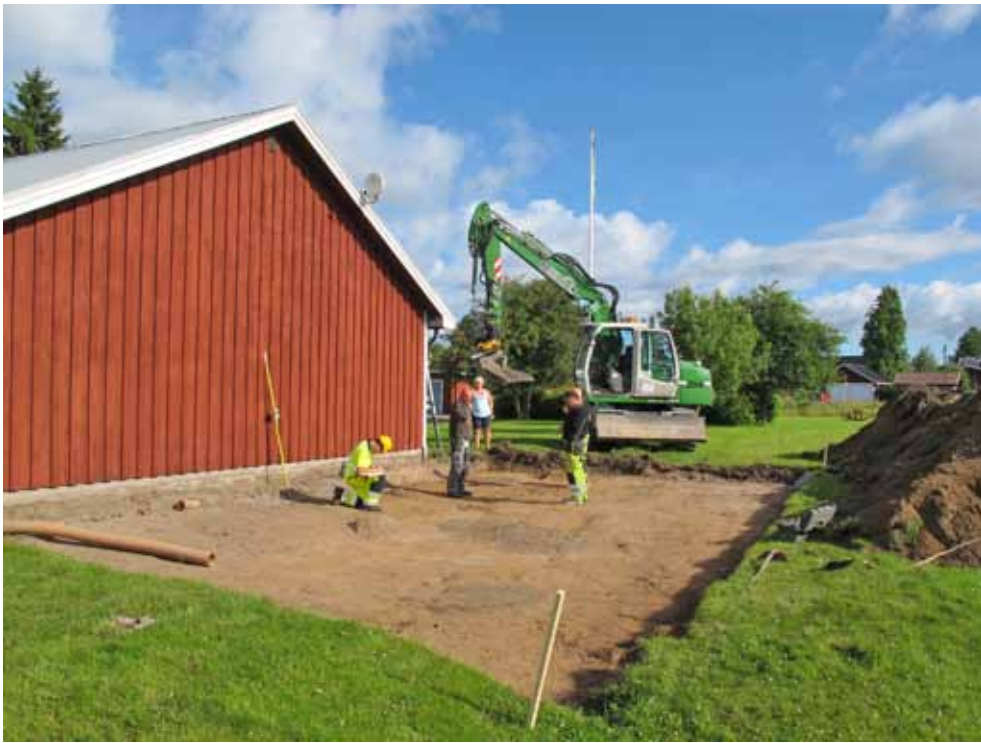
Figur 4. Översikt över undersökningsytan. Fotograferat från sydsydost. Foto Britt-Marie Hägerman.
