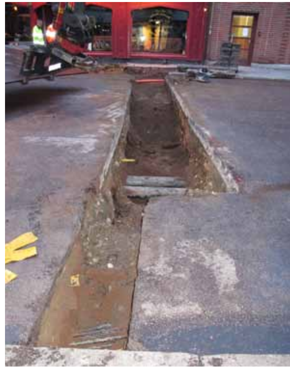
Figur 3. Schaktningen gjordes nattetid då gatan kunde hållas avstängd för trafik. Fotograferat från NV. Foto: Eva Carlsson.
