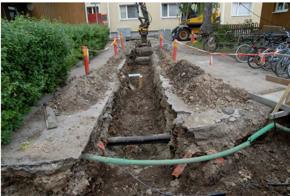
Bilaga 4. Schakt 3. Foto från sydöst. Fotograf Fredrik Sandberg.
