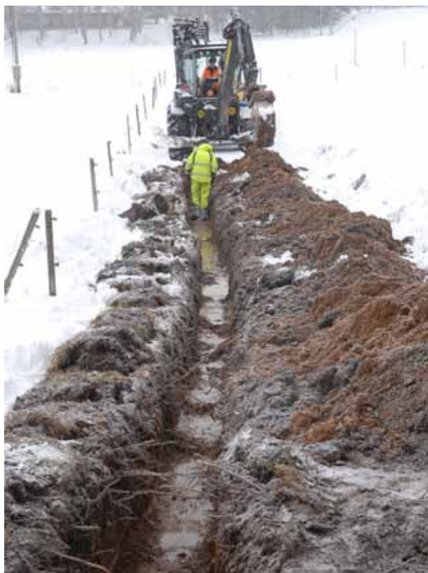
Figur 4. Schakt 1 från ÖNÖ. Foto Fredrik Sandberg.
