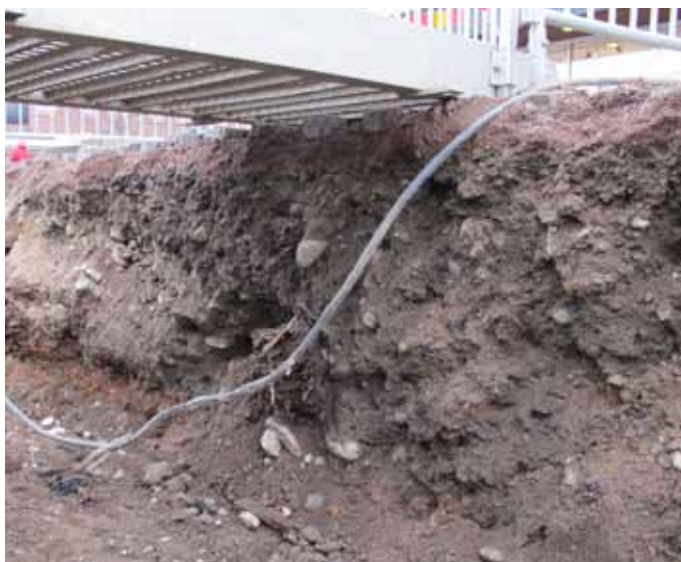
Figur 5. Nordöstra schaktväggen med ledningar och avsliten stock, utanför Åhléns. Fotograferat mot norr. Fotograf Britt-Marie Hägerman.
