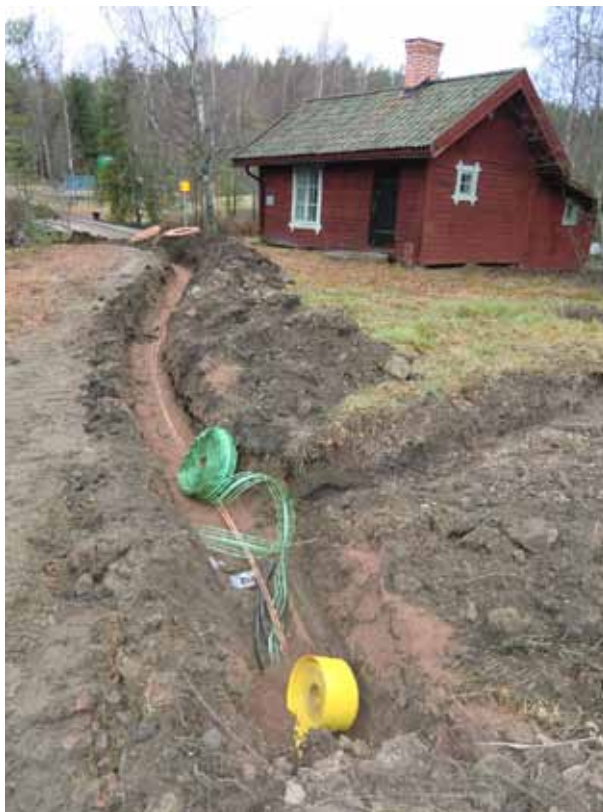
Figur 5. Öster om ån med ån och smedjan i bakgrunden. Schakt 1 med kopparslagglagret som börjar utanför smedjan. Foto mot väster. Fotograf Britt-Marie Hägerman.
