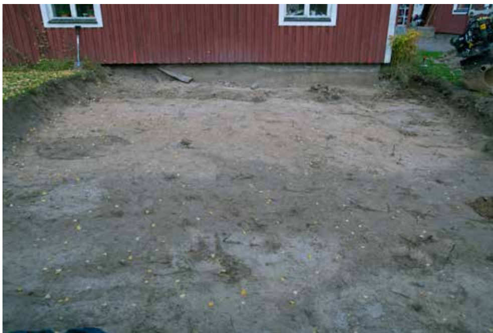
Figur 7. Schaktet med diket (A7) i förgrunden. Foto från SSV, Anna Lögdqvist.
