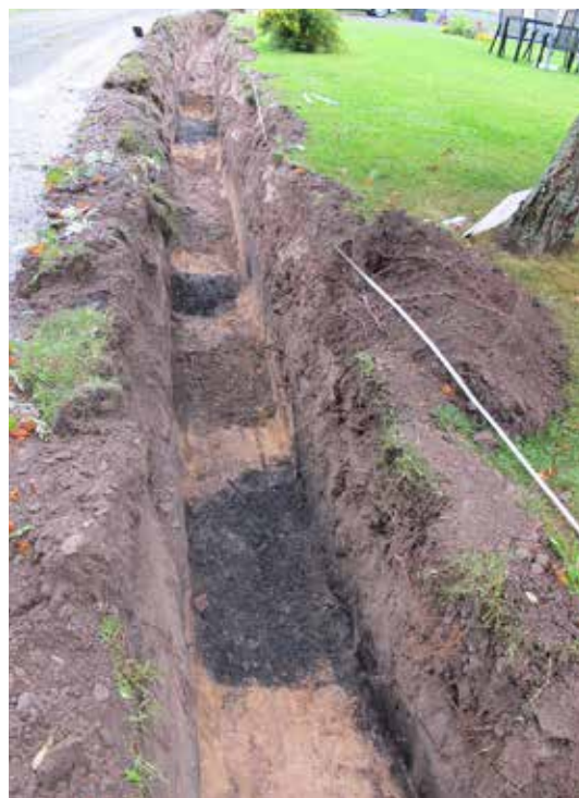
Figur 4. Den sydvästra delen av schaktet med kolningsgroparna A4–A6. Foto från sydväst. Fotograf Joakim Wehlin.
