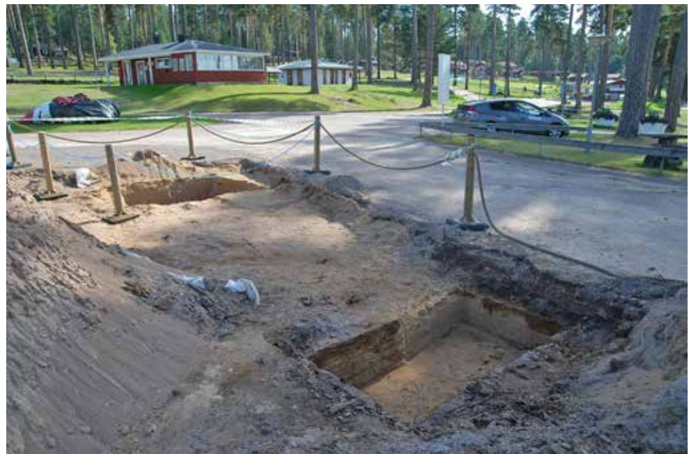
Figur 13. Schakt 2 och 3 i slutskedet av undersökningen. Foto från väst. Fotograf Joakim Wehlin.
