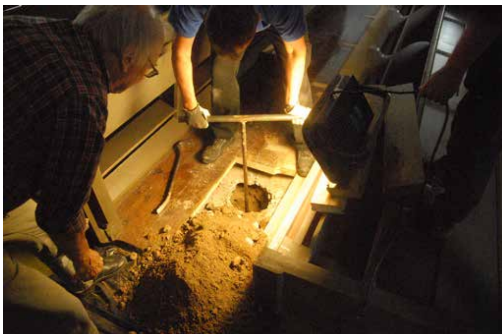
Figur 10. Borrning för hand under bakre raden av de kyrkbänkar som står längst åt nordost i kyrkan. Fotograf Jimmy A Karlqvist
