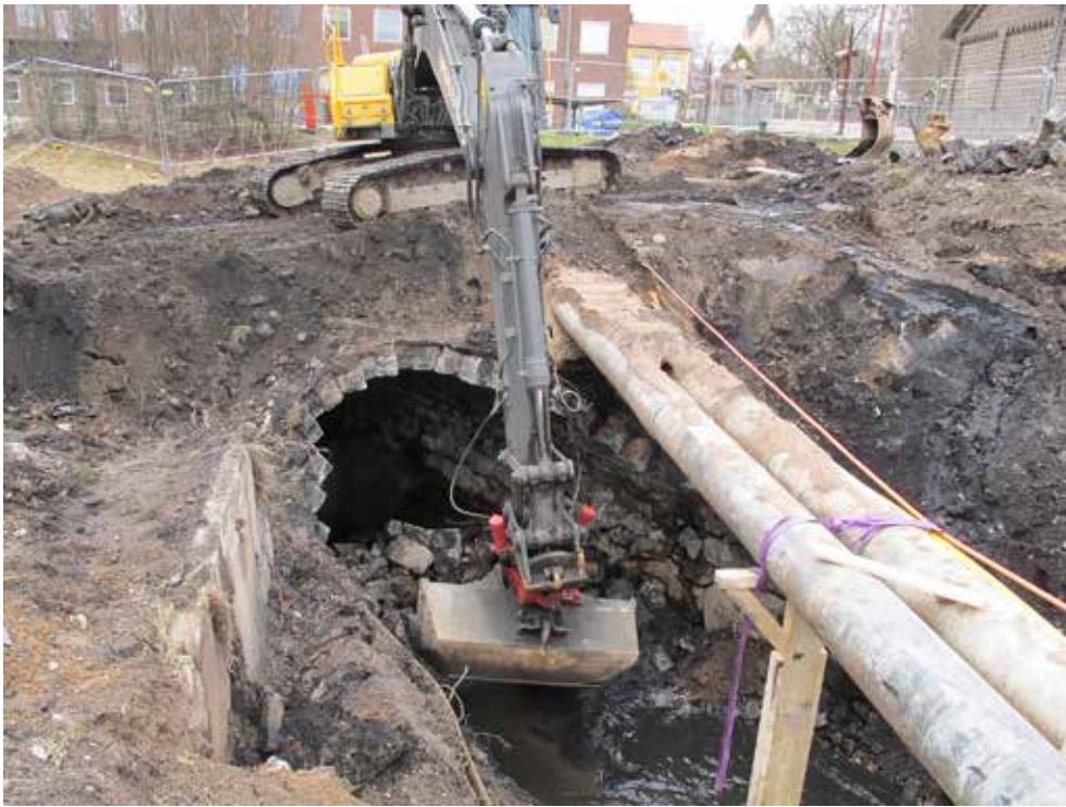
Figur 7. Rivningen av kulvertens valv. Till vänster i bilden syns betongfundamentet. Från nordost, fotograf Jimmy A Karlqvist.
