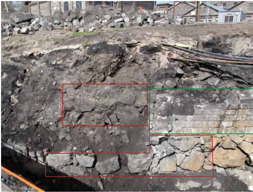
Figur 13. Foto över kanalens nordvästra del. Längst ned syns kanalens mur av natursten ovan den syns slaggstenskulverten, markerat med grönt. Till vänster i bild syns ytterligare en mur av natursten som framkom bakom slaggstenskulverten och ovan kanalens mur. Det kan vara en stödmur eller rester av kopparsmedjans vägg. Foto från sydost, fotograf Jimmy A Karlqvist.
