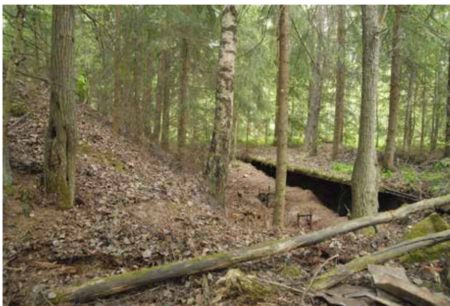
Figur 10. Markörskydd, dike och kulfång till skjutbana. Foto från väst, David Fahlberg.
