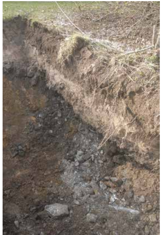
Figur 7. Schaktvägg i schakt 3, från norr. Foto: Greger Bennström.
