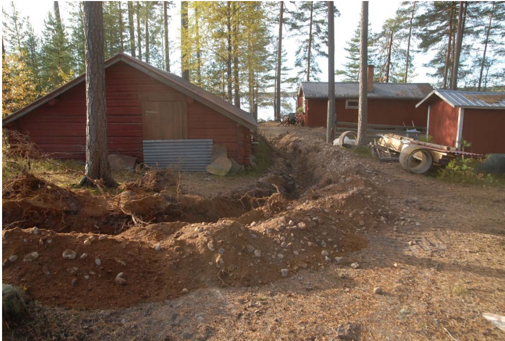
Bild 3. Schaktet grävdes runt uthuset. Foto från norr, Eva Carlsson
