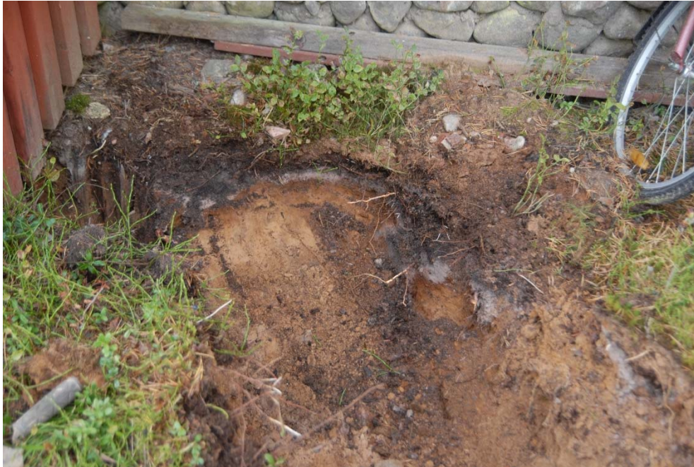
Bild 2. Kollagret syntes närmast fritidshuset och fortsatte i det handgrävda schaktet till vänster, in i den nya utbyggnaden. Foto från norr, Eva Carlsson
