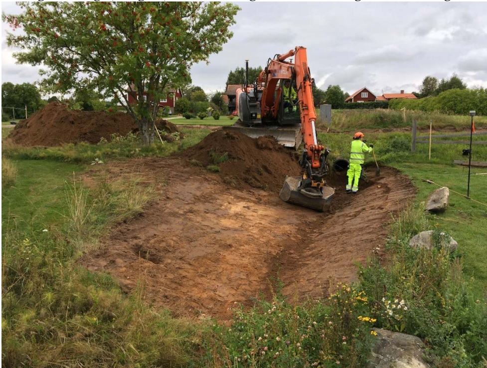
Figur 1. Översikt över schakt 1. Från öst. Fotograf David Fahlberg
