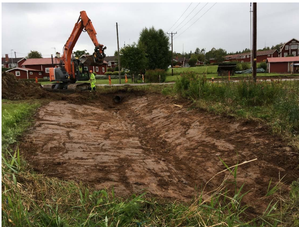
Figur 2. Översikt över schakt 2. Från öst. Fotograf David Fahlberg
