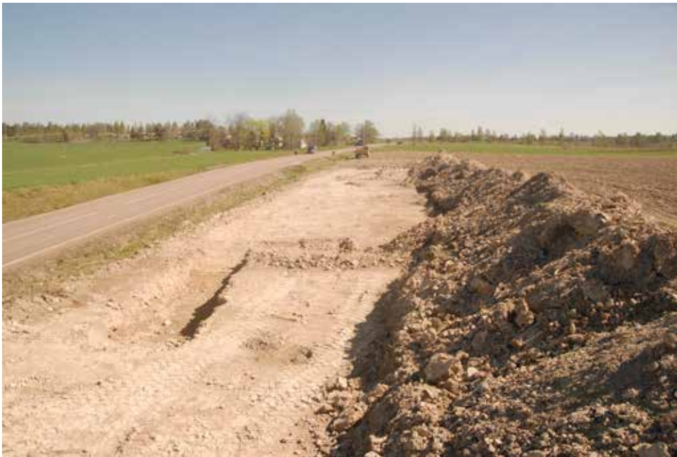
Figur 7. Översikt över Schakt 1, från sydväst. Foto: Mattias Frisk.
