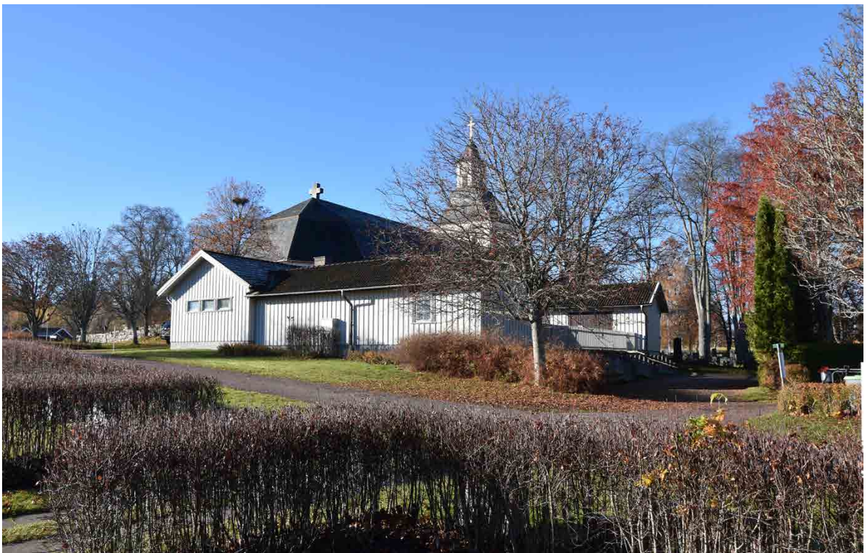
Ekonomibyggnaderna är tillkomna under 1970- och 80-talen efter ritningar av Erik Liljas.
