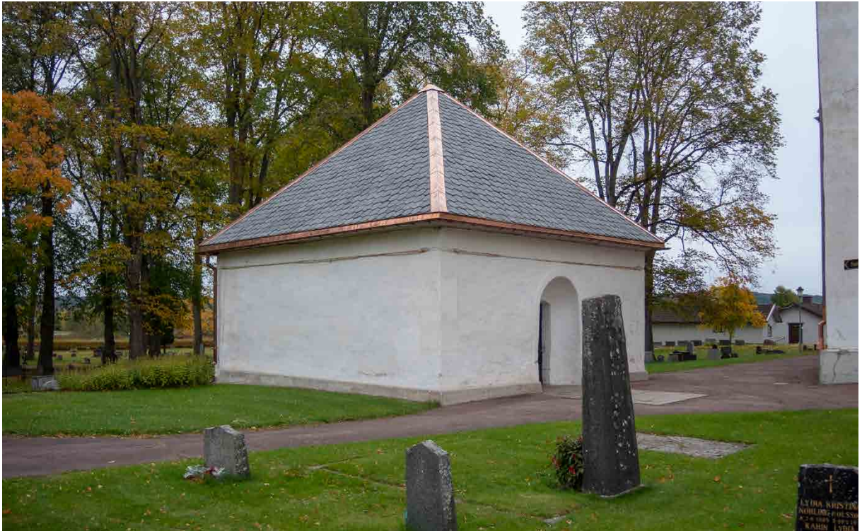
Intill kyrkan står ett gravkapell som ursprungligen uppfördes 1794. Det inreddes till gravkapell på 1940-talet.
