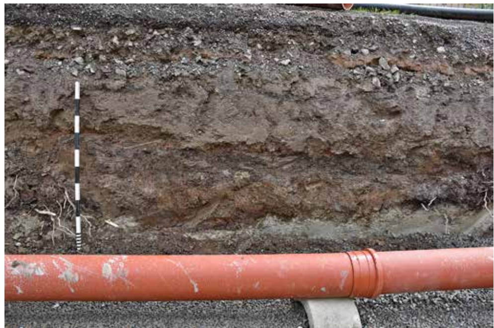
Figur 10. Nedgrävning A1 i sydöstra schaktväggen. Från nordväst. Foto: Lee Widegren Lundin.
