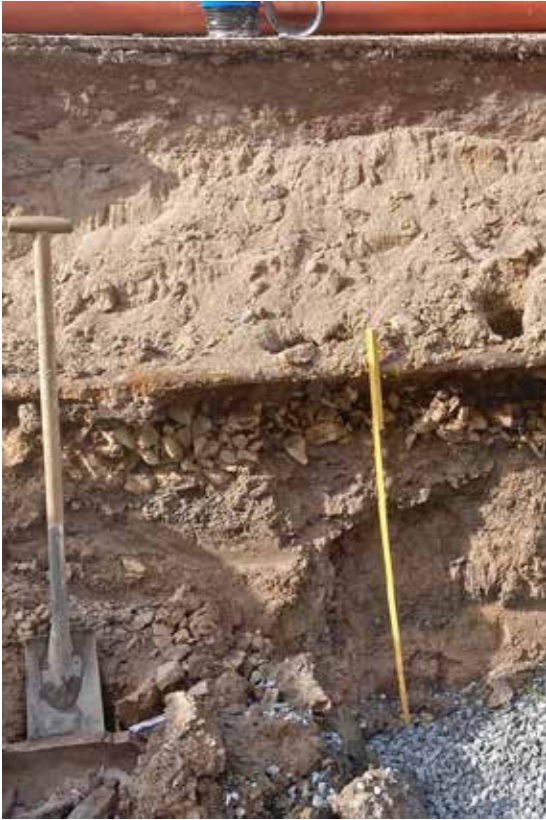
SV schaktväggen, schakt 2. från NÖ. Foto: Lee Widegren Lundin.
