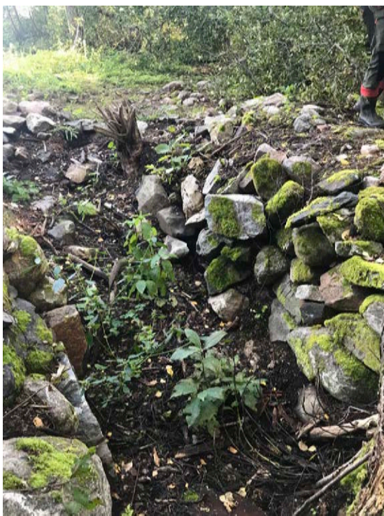
Objekt 12. Den kallmurade källaringången på husgrunden objekt 12 från väster. Foto: Greger Bennström.
