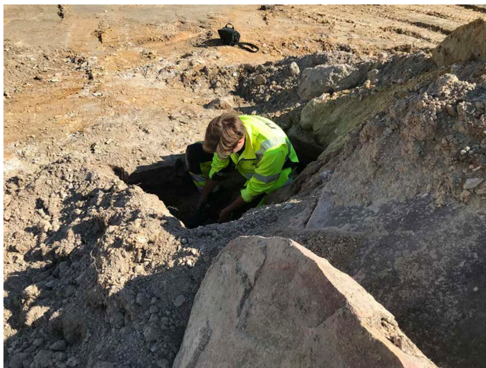
Figur 17. Arbetsbild, Lee försöker ta detaljfoton av takvalvet i källaren A4. Foto: Greger Bennström.
