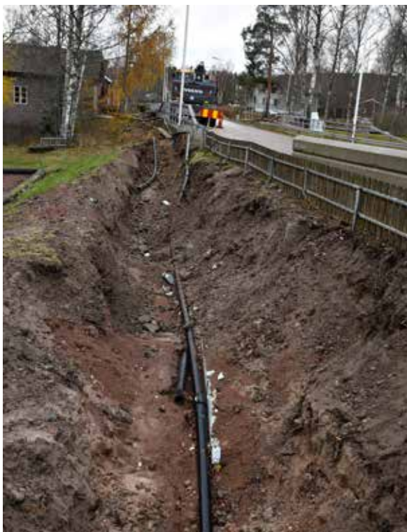
Figur 10. Schakt 3 innehöll främst tidigare omgrävda gruslager, men också slagg. Fotograferat från öster mot Brobäcken. Foto: Eva Carlsson.
