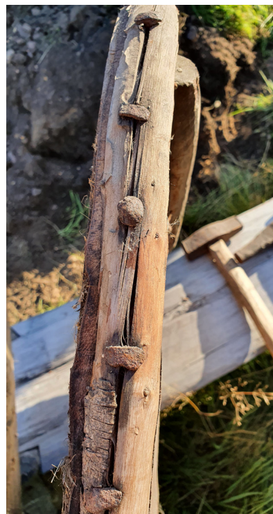
Figur 22. Bälgsstakar med sina karakteristiska avlånga, platta och lite böjda huvuden. Foto: Emelie Svenman.
