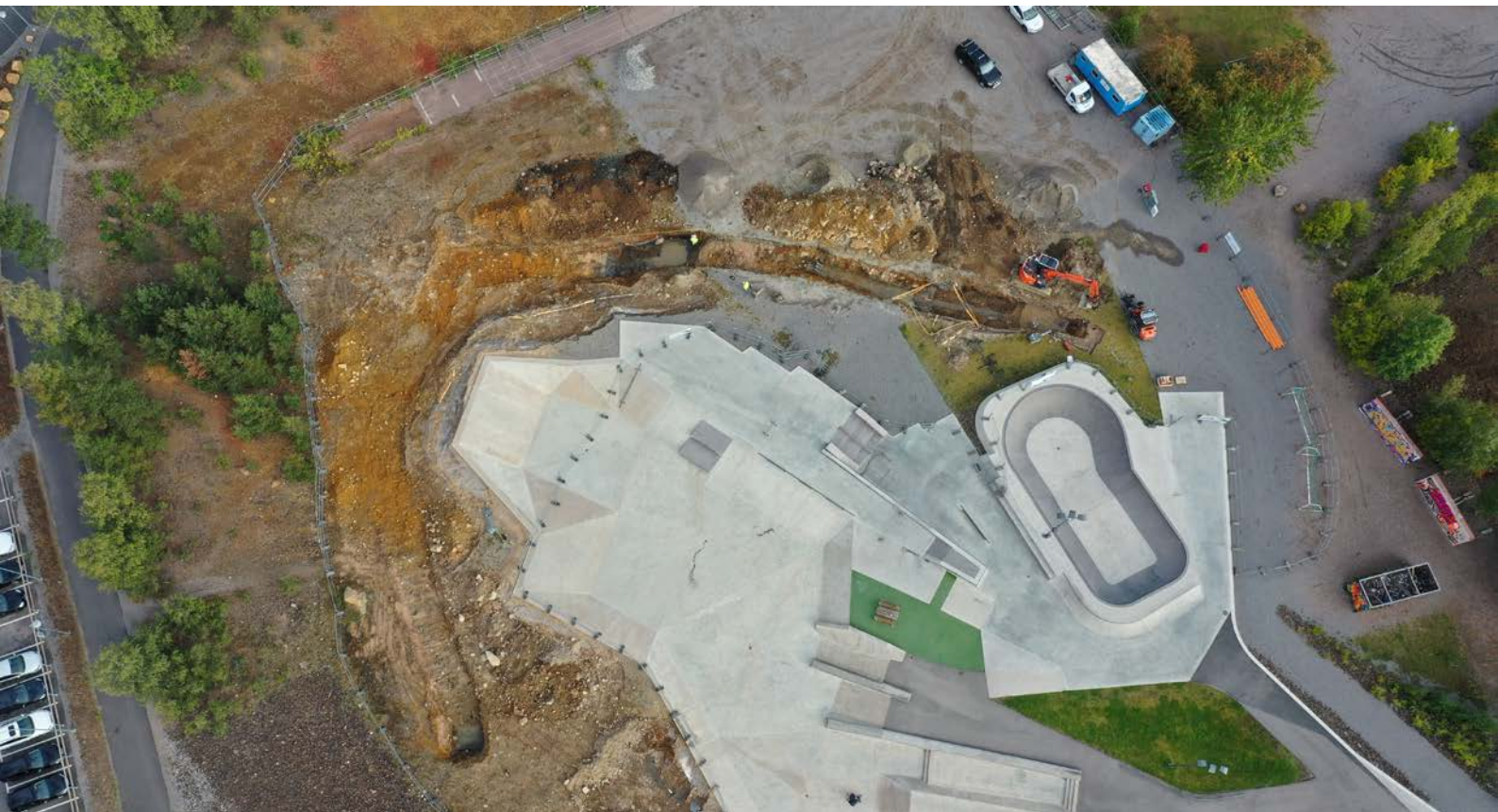
Drönarfoto över schakt 1 rakt ovanifrån. Foto: Jimmy Axelsson Karlqvist.
