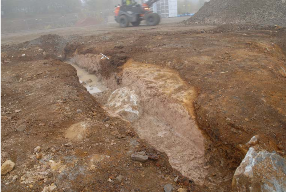
Figur 11. Översikt över schakt 4 sydöstra del, med anläggning A7 längre bort i bild. Foto från söder. Foto: Stefan Östlund.
