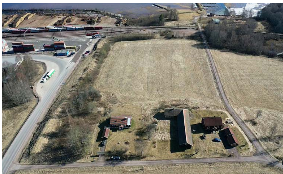
Figur 3: Drönerfoto över det aktuella utredningsområdet. Från sydväst. Foto: Jimmy Axelsson Karlqvist. Publiceras med tillstånd från Lantmäteriet, dnr LM2023/025676.
