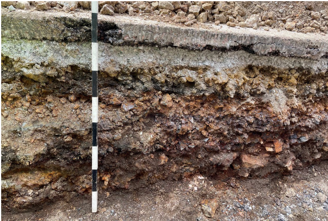
Foto 4: Profilen längs västra schaktväggen såg ungefär likadan ut längs hela Hyttgatan. Kompakta skikt av grusig sand med stora mängder slagg. Plats för fotot markerat i bilaga 1, figur 3. Foto från öst. Fotograf: Linda Wigert.
