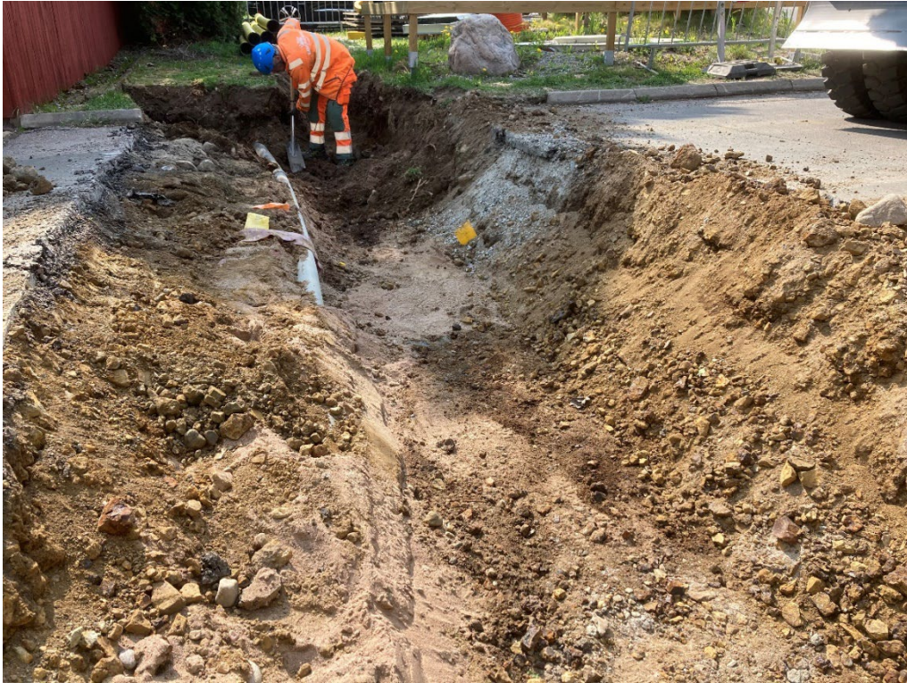
Foto 5: Schaktet där det korsar Hyttgatan i sydväst. Område A i förgrunden och B i bakgrunden. Äldre ledningar var dragna tvärs över gatan och längs med den. Strax vänster om personen på bilden kan man skymta kullerstenen som påträffades direkt under asfalten. Foto från nordöst. Fotograf: Lee Widegren Lundin.
