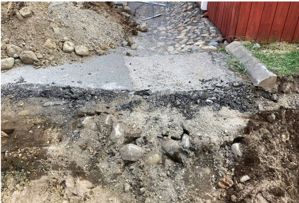
Foto 6: Den äldre gatläggningen, av kullersten, framkom i schaktets sydvästra del. Foto från nordväst. Fotograf: Lee Widegren Lundin.
