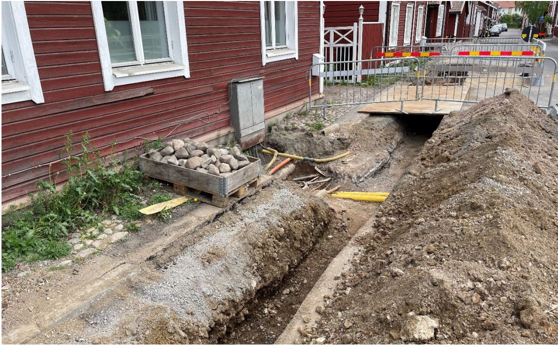
Foto 3: Majoriteten av schaktväggarna innehöll av relativt moderna fyllnadsmaterial ovanpå ledningar. Längs husväggarna låg kullerstenen kvar. Vid elskåpet hade kullerstenen varsamt plockats upp för att senare läggas tillbaka. Foto från nordväst. Fotograf: Linda Wigert.
