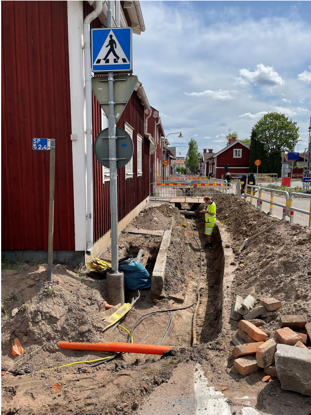
Foto 2: Lee dokumenterar lagerföljden i norra änden av schaktet, vid hörnet av Hyttgatan och Gruvgatan. I norr bestod fyllnadsmaterialet främst av påförd sand. Längre söderut i schaktet, där Lee står, bestod de äldre fyllnadsmassorna i vägen främst av slagg. Foto från norr. Fotograf: Linda Wigert.
