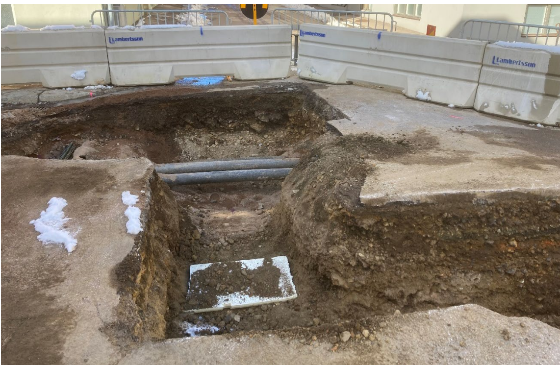
Foto 2. Översikt norra delen av schaktet från SÖ. Foto: Lee Widegren Lundin.
