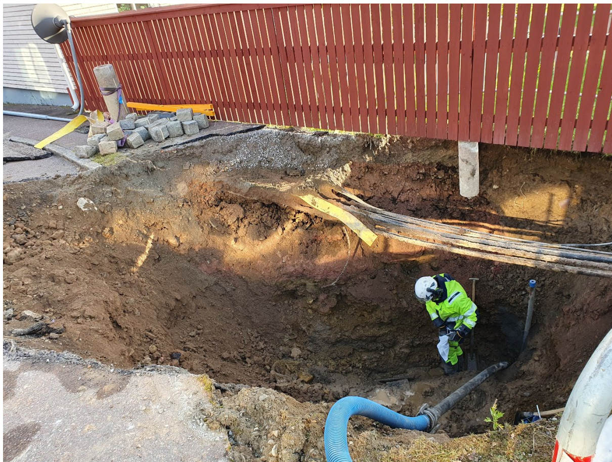
Foto 1. Översiktsbild av schaktet från SV. Foto: Emelie Svenman.
