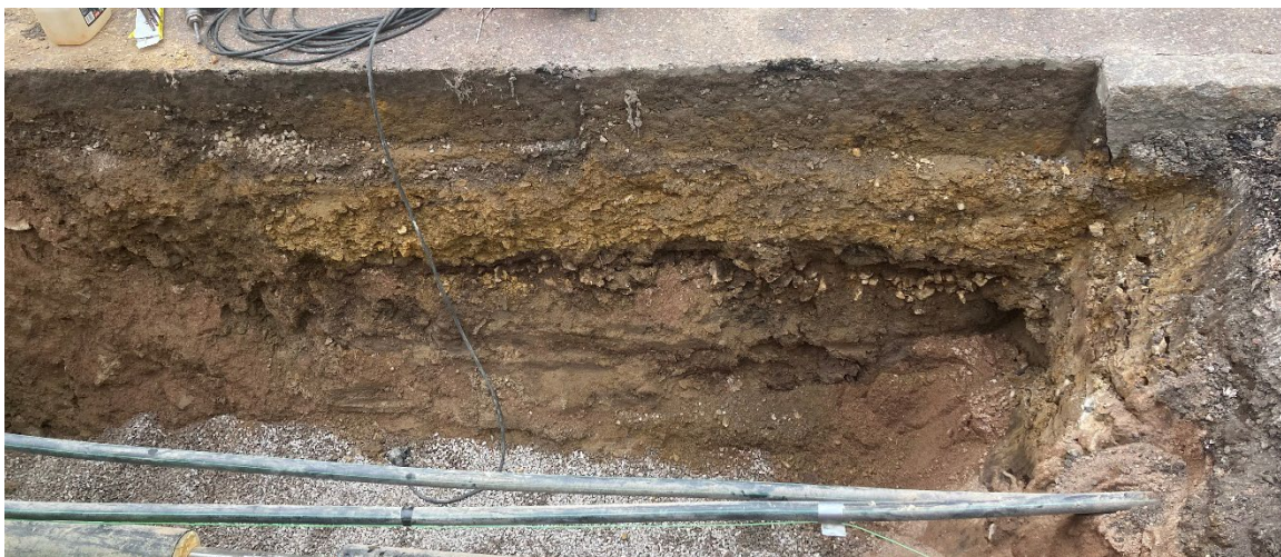
Foto 2. Schakt 1b, sydvästra schaktväggen mot trottoaren, från nordöst. Foto: Lee Widegren Lundin.
