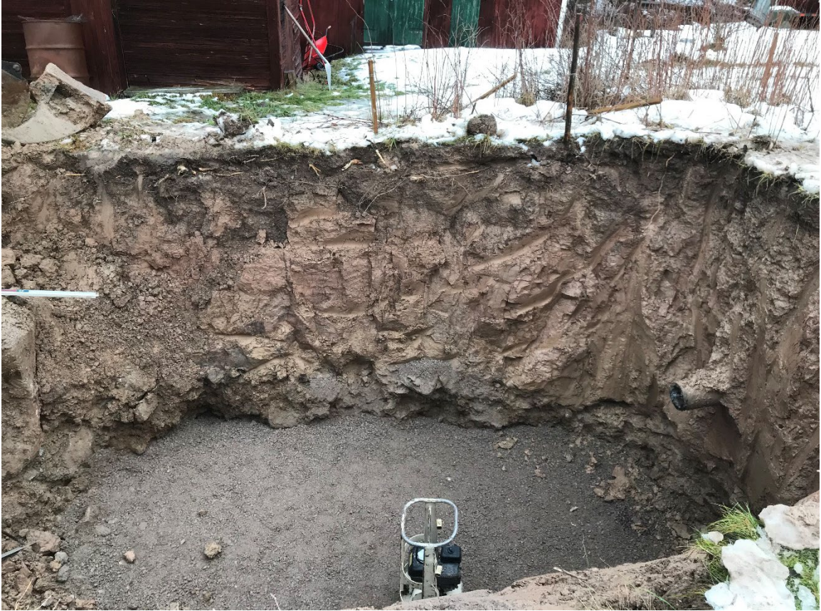
Foto 2: Schakt 1 från sydväst. Foto: Greger Bennström.
