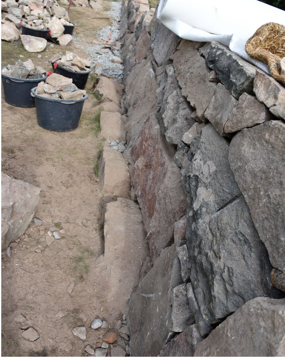
Foto 6. Grundstenarna från den äldre muren SSK3 från söder. Foto: Greger Bennström.
