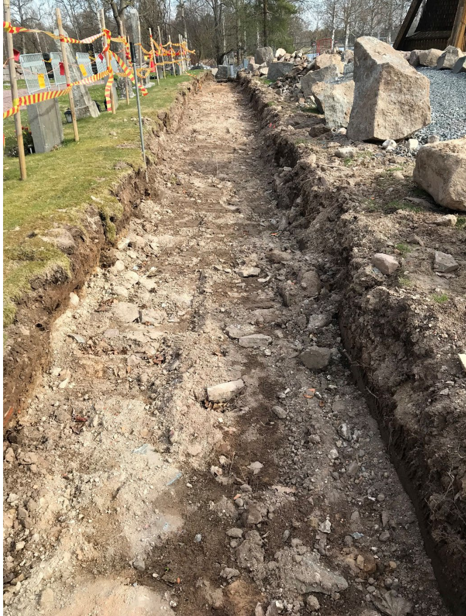
Foto 3. Schaktet vid sektion 2 från söder. Foto: Greger Bennström.
