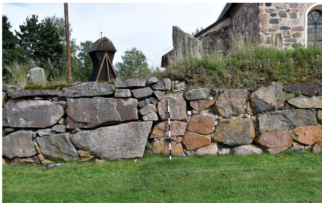
Foto 5. Skarven mellan sektion 4 (t.h.) och sektion 5 (t.v.). Foto: Greger Bennström.
