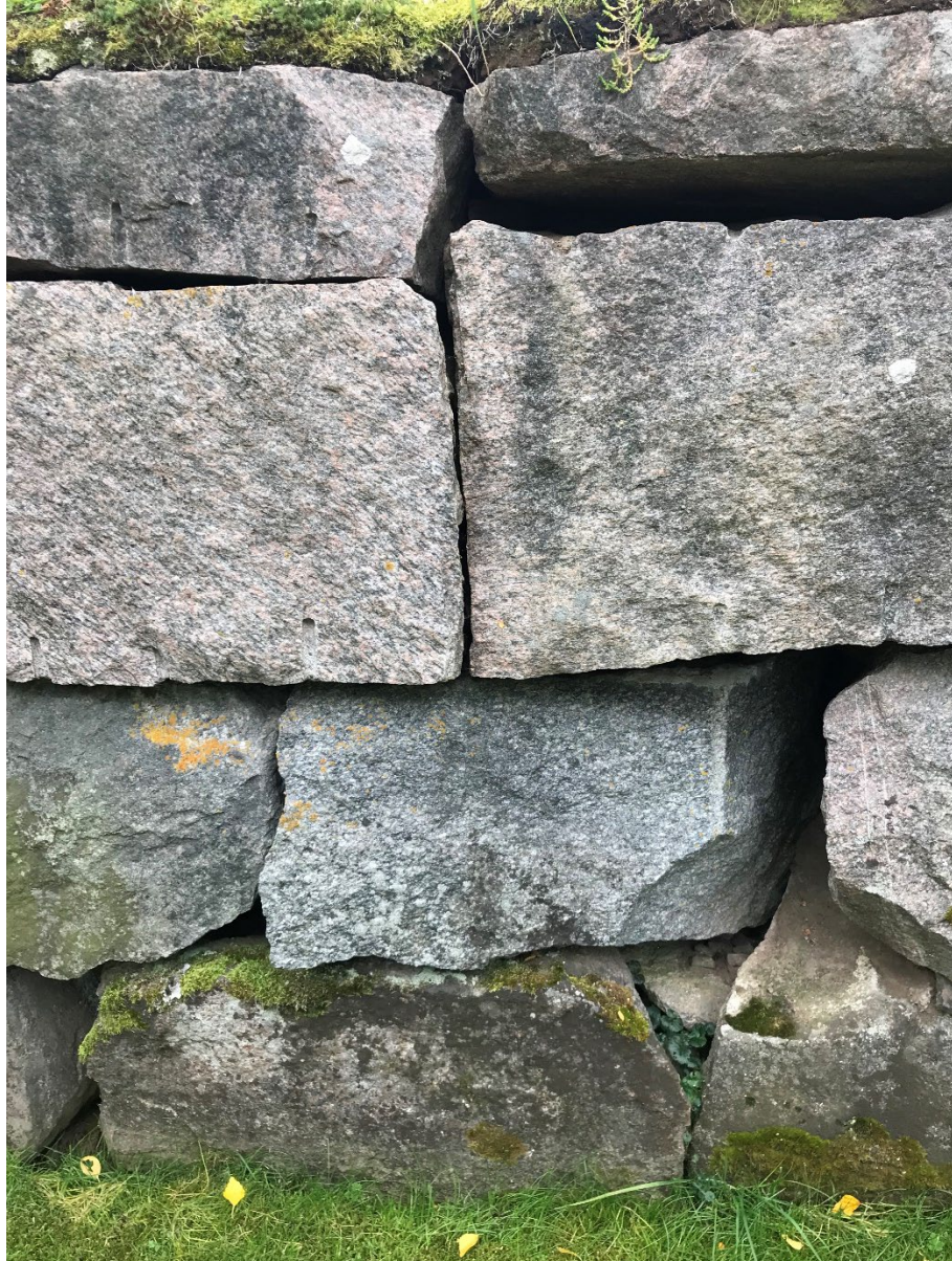
Foto 4. Sektion 3 med blå granit underst och röd granit över. Foto: Greger Bennström.
