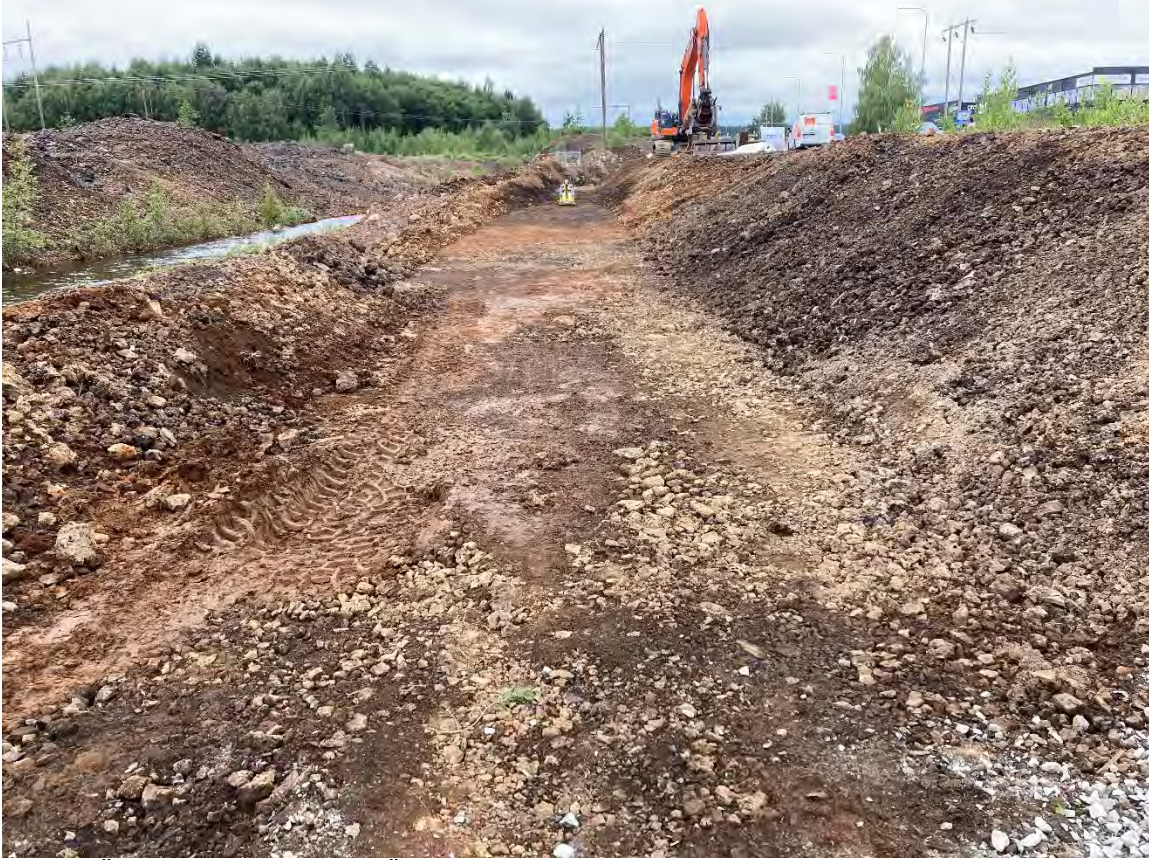
Foto 9. Översikt schakt 12, från Ö. Foto: Lee Widegren Lundin.
