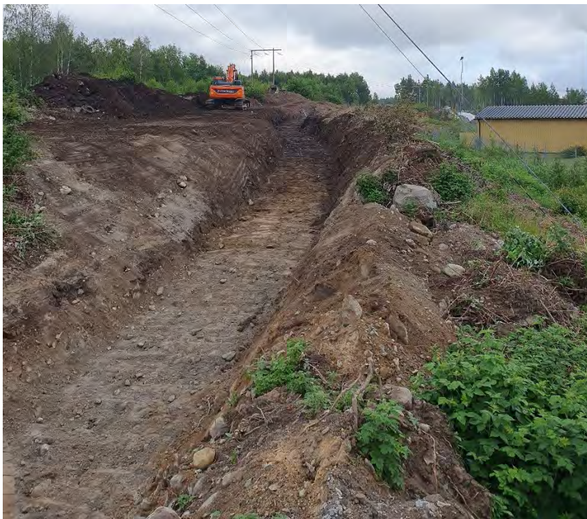
Foto 4. Översikt från sydöst, schakt 5. Deponimassor. Foto: Emelie Svenman.
