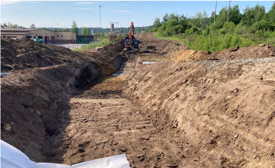
Foto 3. Översikt från norr, schakt 2. Det mörkare partiet till vänster i schaktväggen, lager 5, innehöll slagg, recenta föremål och kisbränder. Annars recenta material i deponimassorna som syntes i schaktväggen. Foto: Lee Widegren Lundin.
