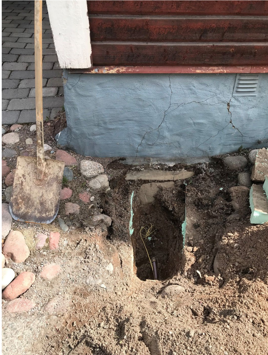
Foto 1. Schaktet fotograferat från sydväst. Foto: Greger Bennström.
