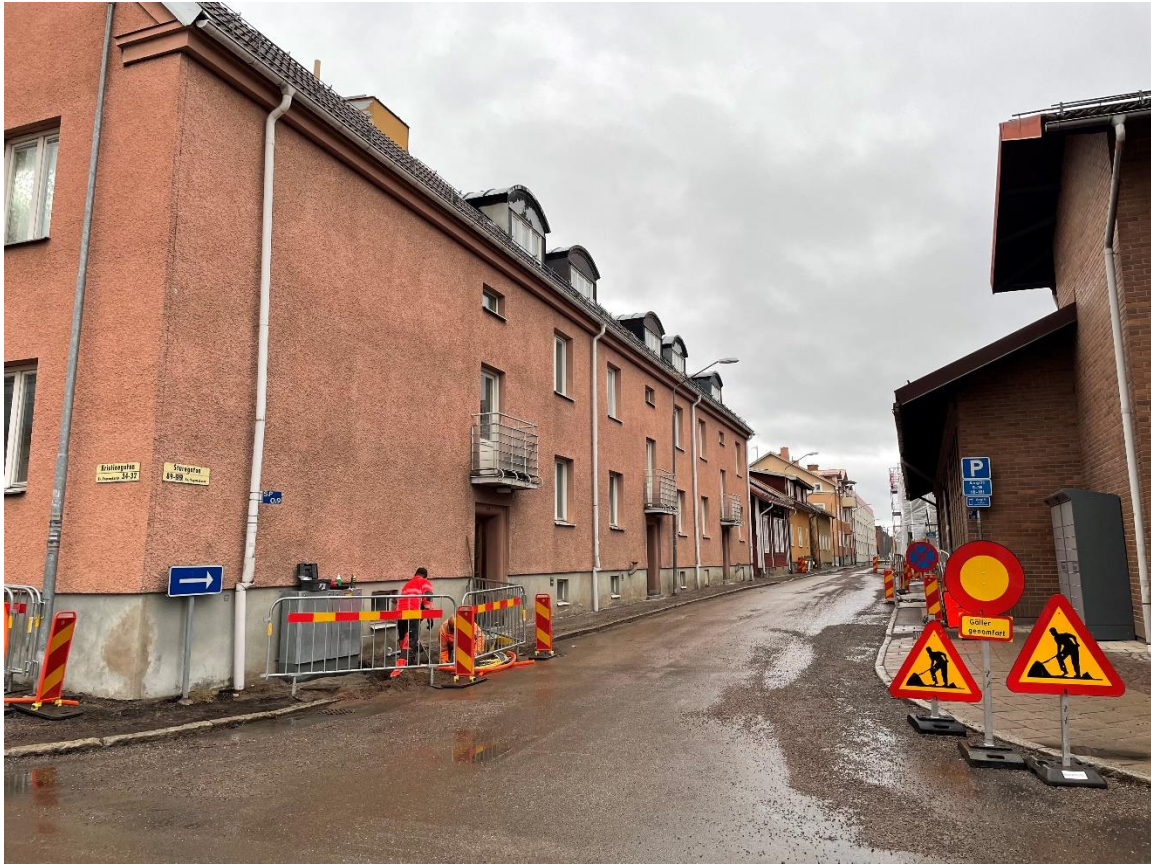
Foto 2: Översikt Sturegatan 72-89, från korsningen Sturegatan-Kristinegatan. Det igenlagda schaktet löpte längs husväggen till vänster i bild. I förgrunden pågår arbetet med att koppla in de nya ledningarna. Foto mot nordväst. Fotograf: Linda Wigert.
