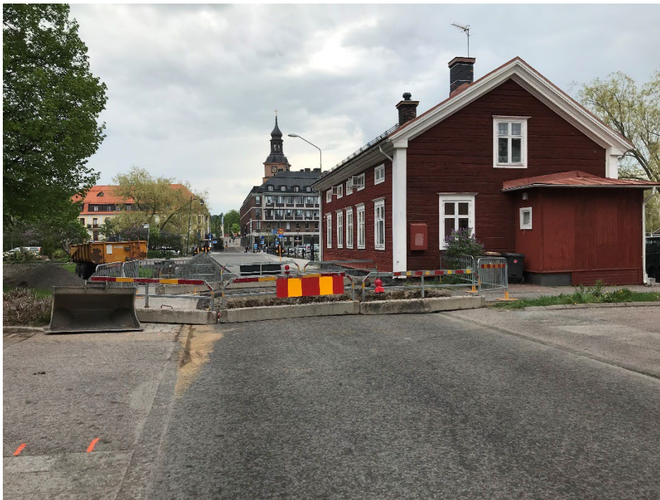
Foto 1. Översiktsbild från sydväst med schaktets placering i Kristinegatan. Foto: Greger Bennström.
