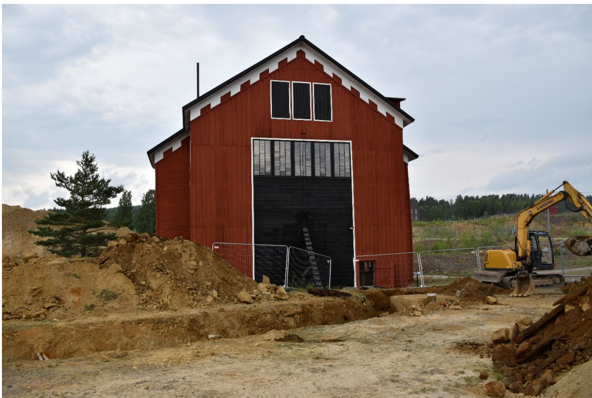
Foto 1. Schaktet och Creutz spelhus sett från nordöst. Foto: Greger Bennström.
