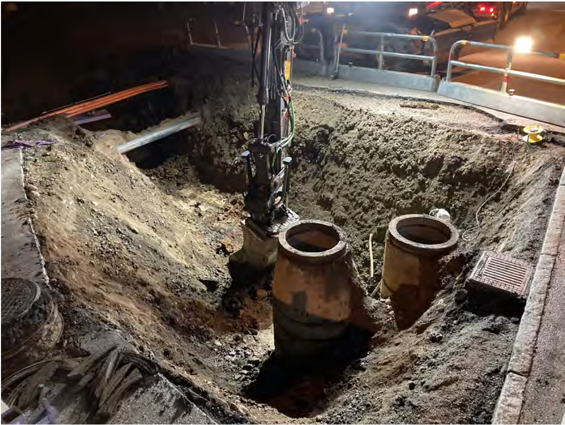
Foto 1. Översikt schakt, projekt 677, från nordväst. Foto: David Fahlberg.
