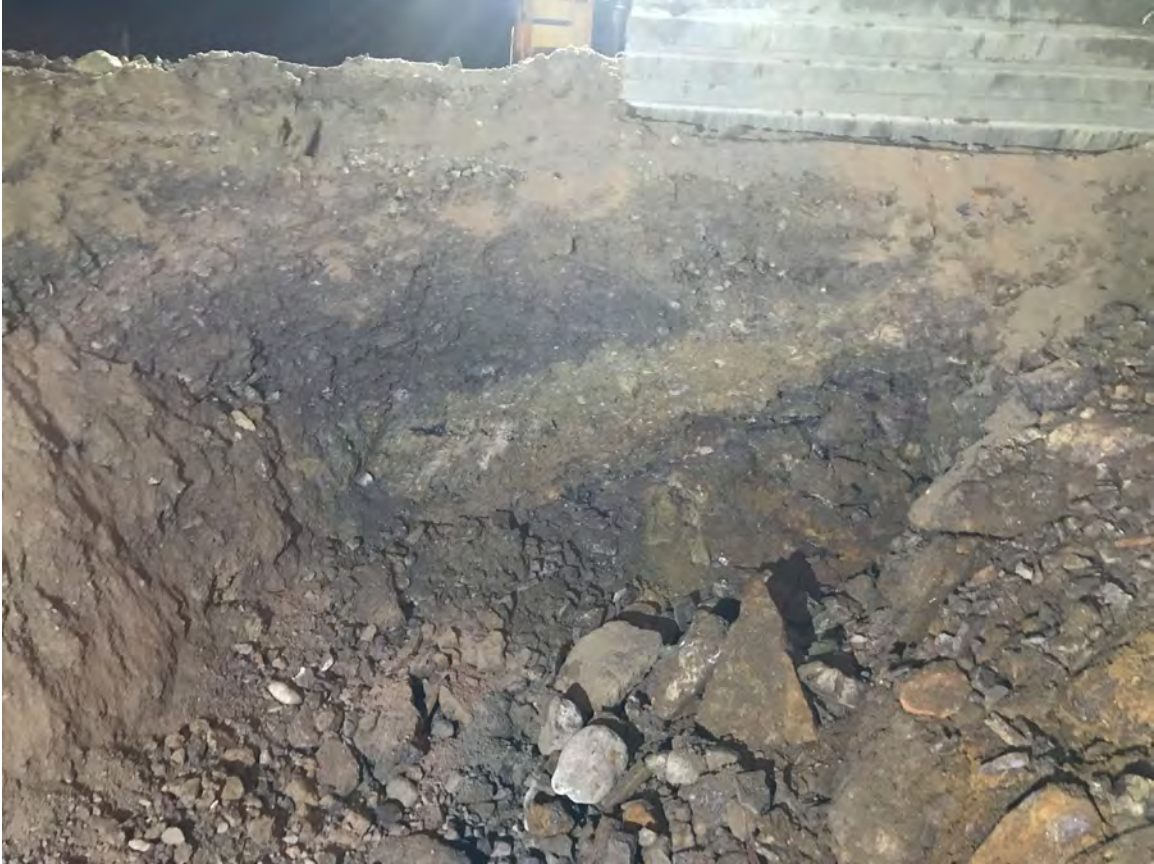
Foto 2. Bevarade lager synliga i den sydöstra schaktväggen. Det svavelgula lerblandade lagret och underliggande utfyllnadslager sluttar synbart mot öster. I botten av schaktet syntes kantiga stenar som låg blandade med slaggen i den understa utfyllnaden, här ännu inte urgrävd. Foto från nordväst: David Fahlberg.
