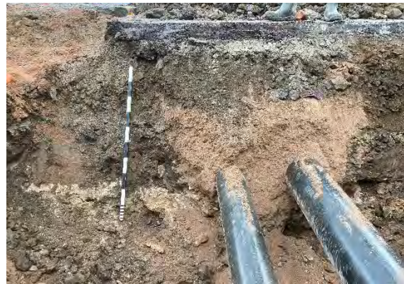
Figur 3: Del av sydöstra schaktväggen med kabelnedgrävning från nordväst. Foto: Lee Widegren
