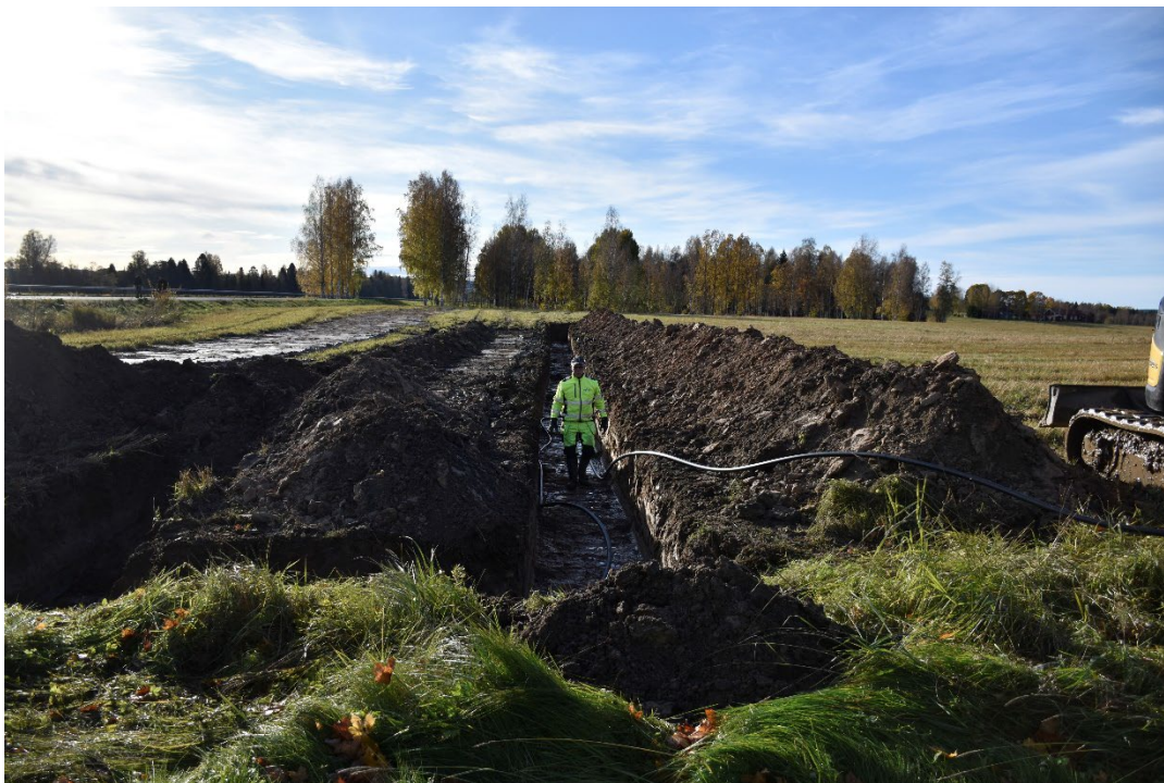
Foto 6. Översikt schakt 3. Från N. Foto: Emelie Svenman
