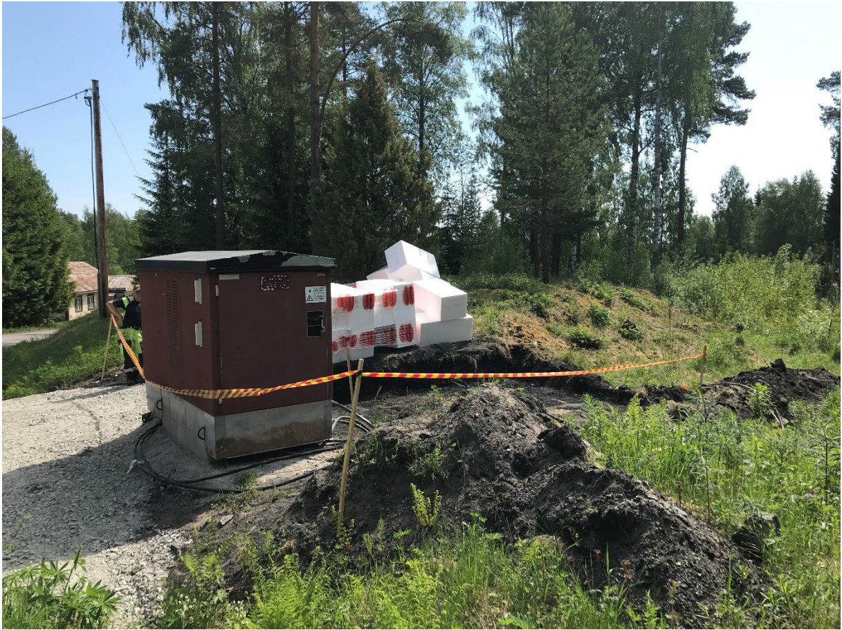
Översikt från nordväst, i bakgrunden skogbeväxt skrotstensvarp. Den gamla transformatorstationen till vänster om schaktet. Foto: David Fahlberg.
