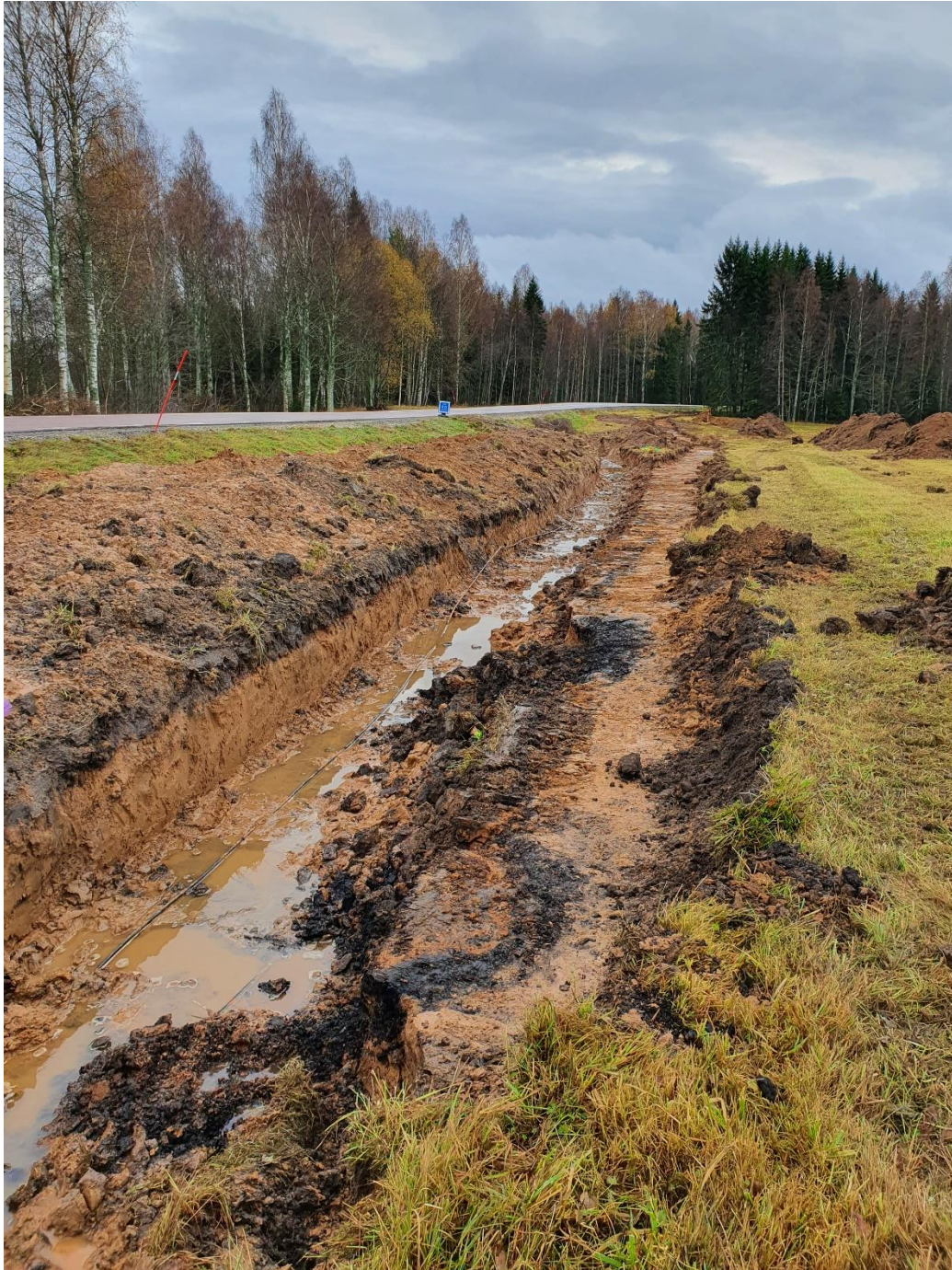
Figur 3.2. Schakt 1, norra delen med A1 och A2. Äldre kabelschakt till vänster i vild. Från N. Foto: Emelie Svenman
