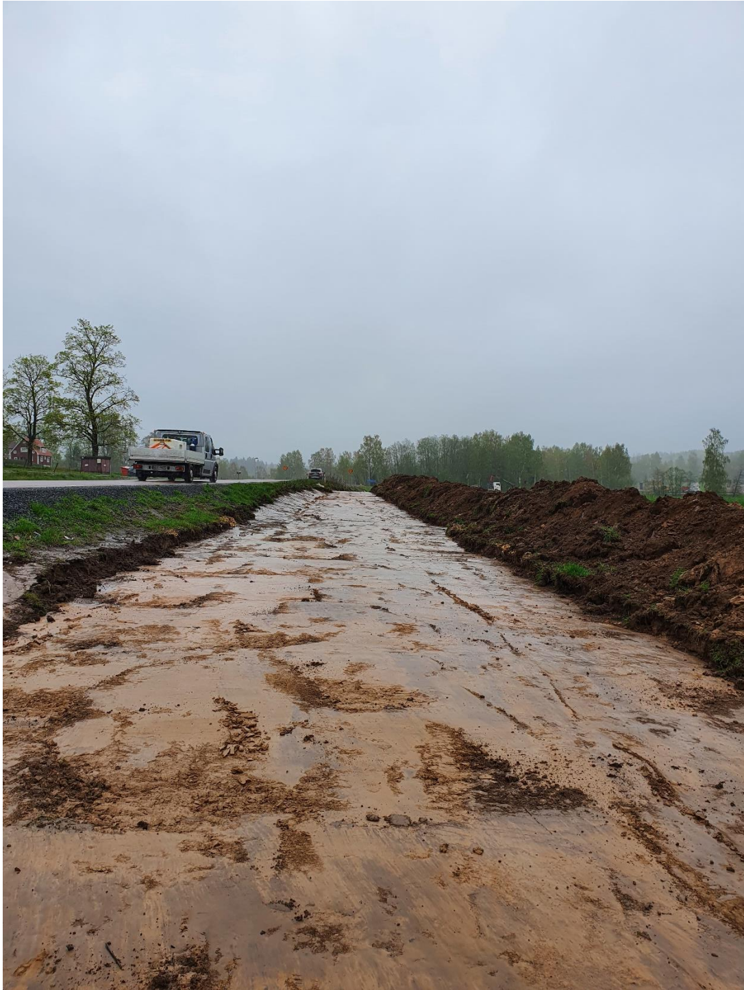
Figur 4.2. Schakt 4 (fortsättning på schakt 3). Från SV. Foto: Emelie Svenman
