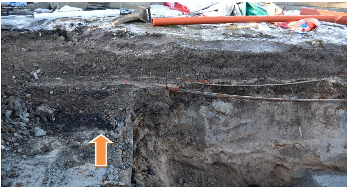
Figur 1: Schakt 3 påbörjad schaktning (t.v.) och schakt 2 (t.h.) Slagglagret syns under ledningarna i västra schaktväggen och precis i ytan där vägens bärlager precis grävts bort. Från öst. Foto: Lee Widegren Lundin.
