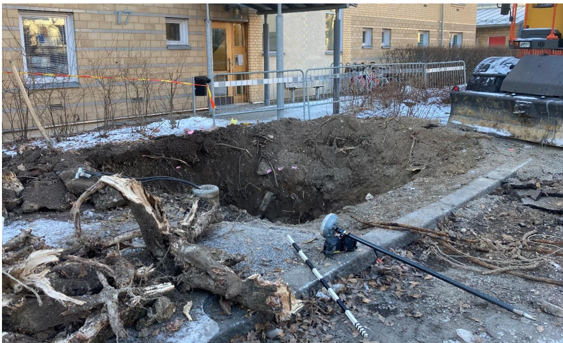
Figur 1: Översikt över schaktet utanför Bergmästaregatan 17. Från OSO. Foto: Lee Widegren Lundin.
