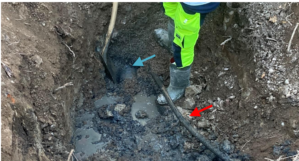
Figur 2: Detaljbild på leran (röd pil) som framkom i botten vid stöveln med rör nedgrävt till vänster. Notera att leran är svart runt röret i nedgrävningen (blå pil). Från NO. Foto: Lee Widegren Lundin.
