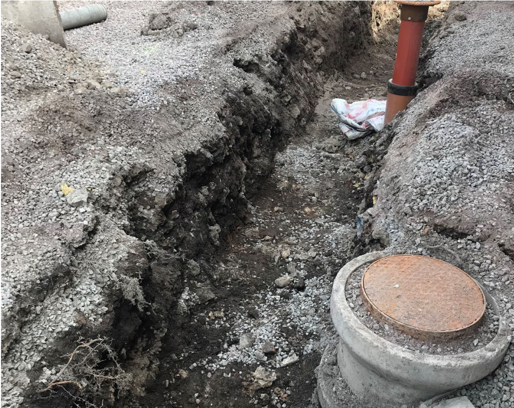
Foto 1. Översikt av del av schaktet inne på gården från sydväst. Foto: Greger Bennström.
