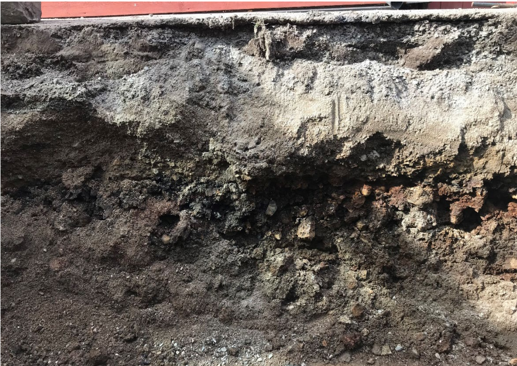
Foto 2. Schaktväggen in mot huset (SV) i schaktet ute i gatan. Överst moderna fyllnadsmaterial (ljusgrått), sedan ren kopparslagg (rostrött) och underst uppblandad slagg (mörkgrått). Foto: Greger Bennström.
