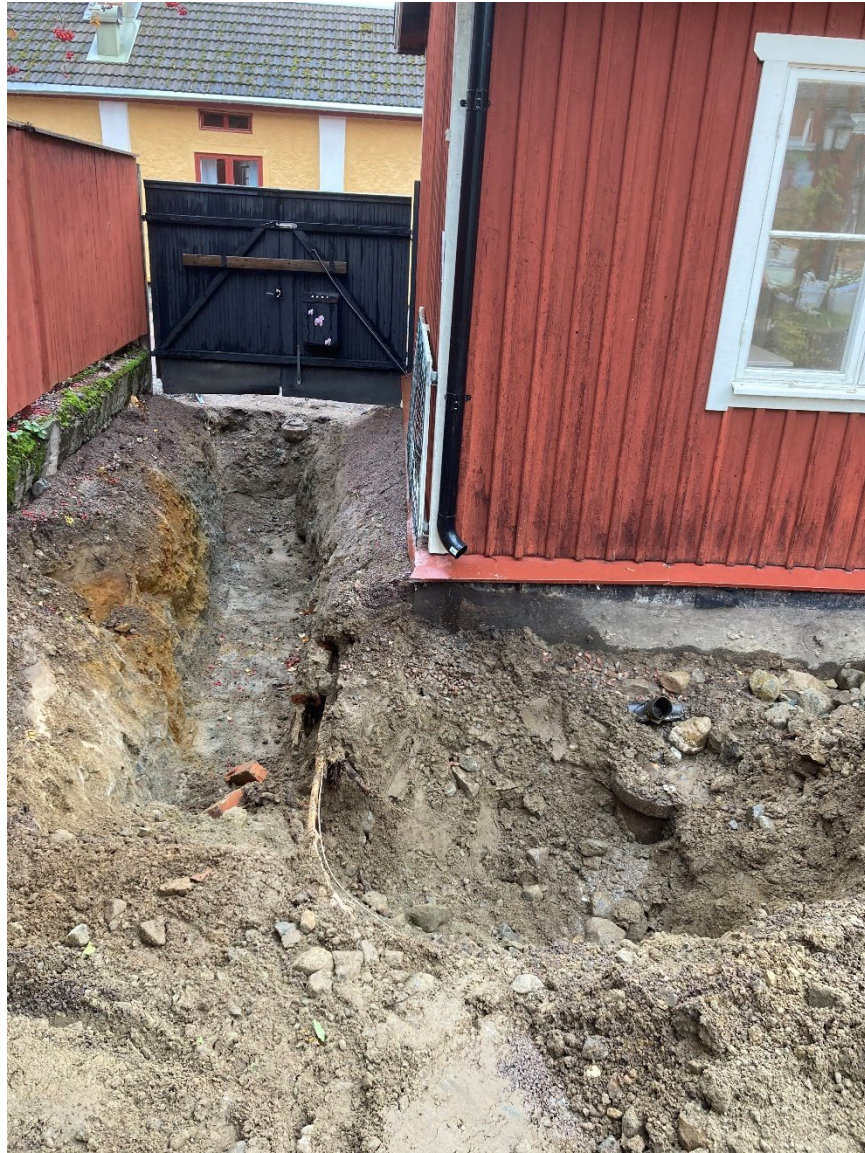
Figur 2. Översikt över del schaktet inne på tomten innanför porten, ej färdigschaktat. Från sydväst. Foto: Lee Widegren Lundin.
