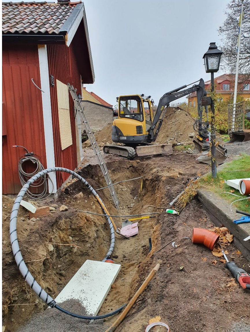
Figur 3. Översikt över del av schaktet fram till farstun. Fotat från nordväst. Foto: Emelie Svenman.
