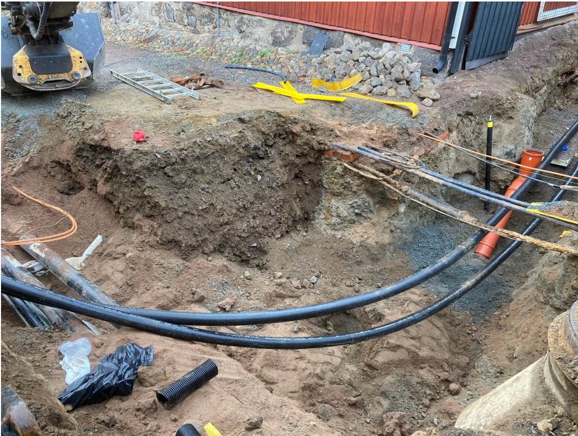
Figur 1. Översikt schaktet i Sturegatan. Notera stenblocket (B) uppe till höger i bild under den svarta porten. Från nordnordost. Foto: Lee Widegren Lundin.
