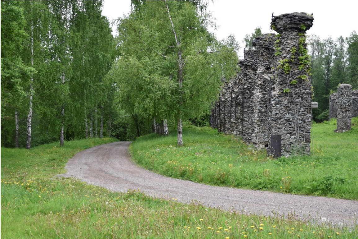
Figur 3: Kolhusruin öster om grusvägen där schakt skulle komma att grävas, från syd. Foto: Lee Widegren Lundin.
