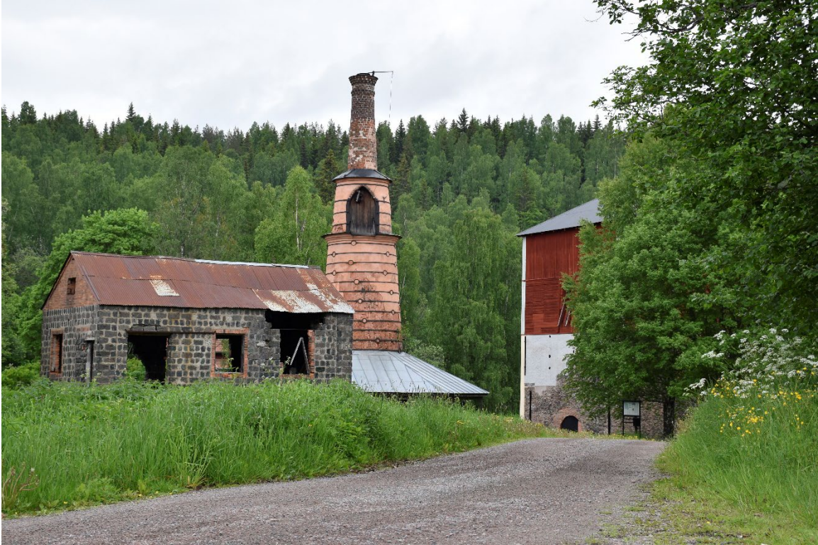
Figur 1: Översikt hyttbyggnader före schaktning. Schaktning skulle komma att ske utmed grusvägen. Från vänster syns sintringsverket, rostugnen och masugnen. Foto från sydöst. Foto: Lee Widegren Lundin.
