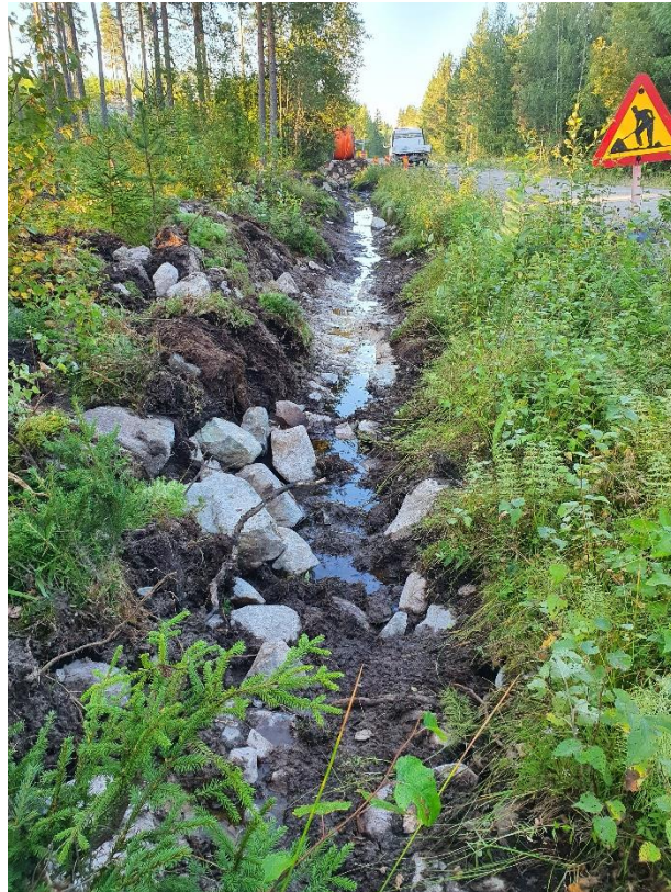
Bilaga 2.3. Översikt, schakt 2. Fotat från NO. Foto: Emelie Svenman
