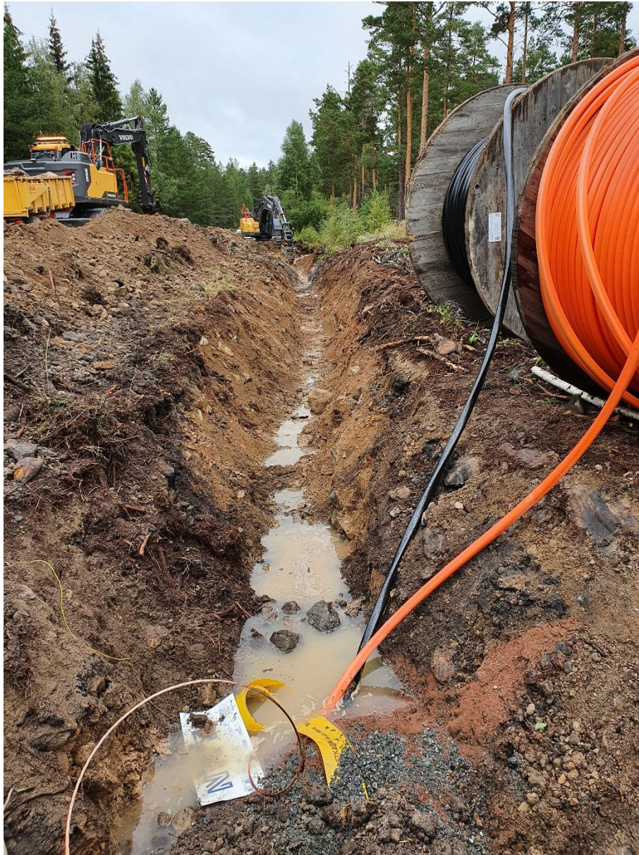
Bilaga 2.1. Översikt, schakt 1. Fotat från SV. Foto: Emelie Svenman
