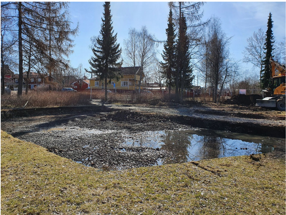
2.2. Översiktsbild över schakt 2. I botten av schaktet syns det slaglager som påträffades i schakt 1,2 och 3. Till höger i bild ser man att schaktet börjat vattenfyllas. Fotat från NV. Foto: Emelie Svenman
