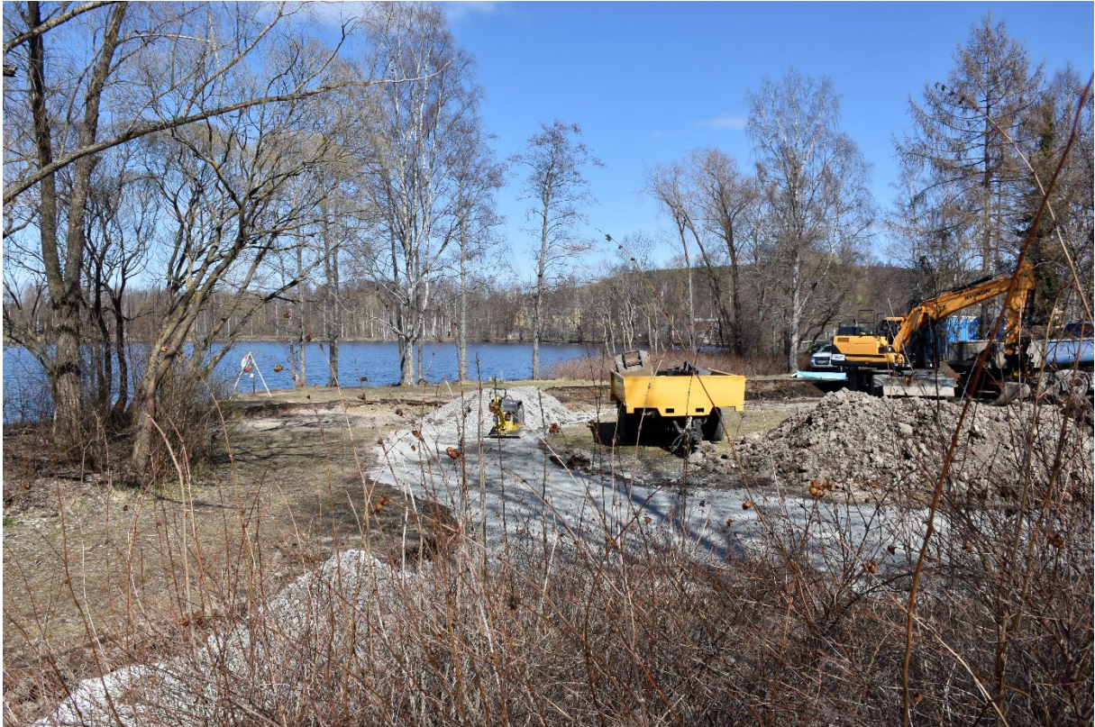
2.1. Översiktsbild tagen mot schakt 1,2 och 3 med Östanforsån i bakgrunden. Fotat från S. Foto: Eva Carlsson
